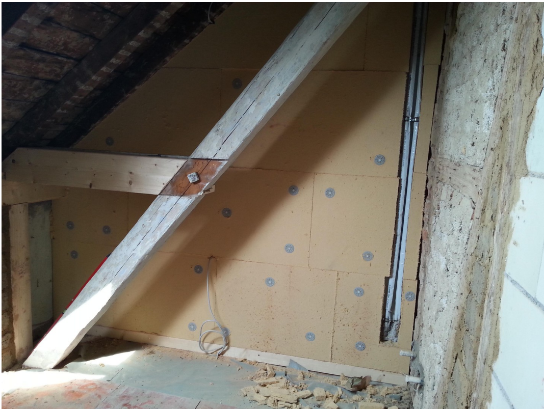
Giebel m. Holzfaserdämmplatten
