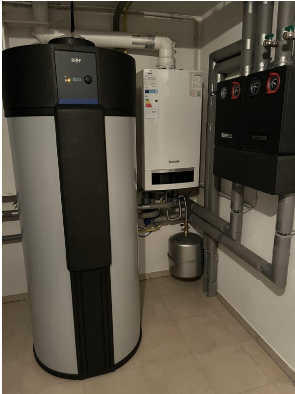
Brauchwasserwärmepump
