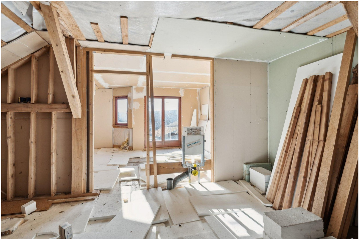
Neuer Teil DG
