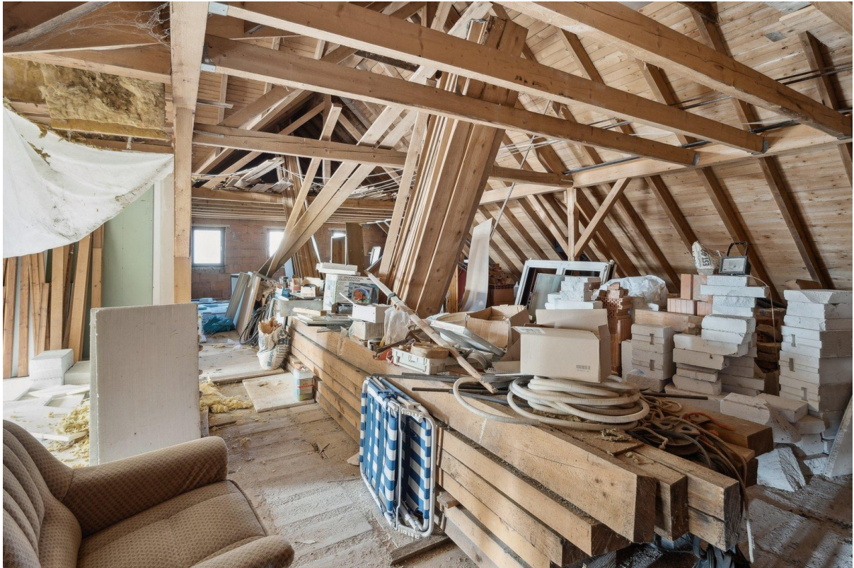
Neuer Teil DG
