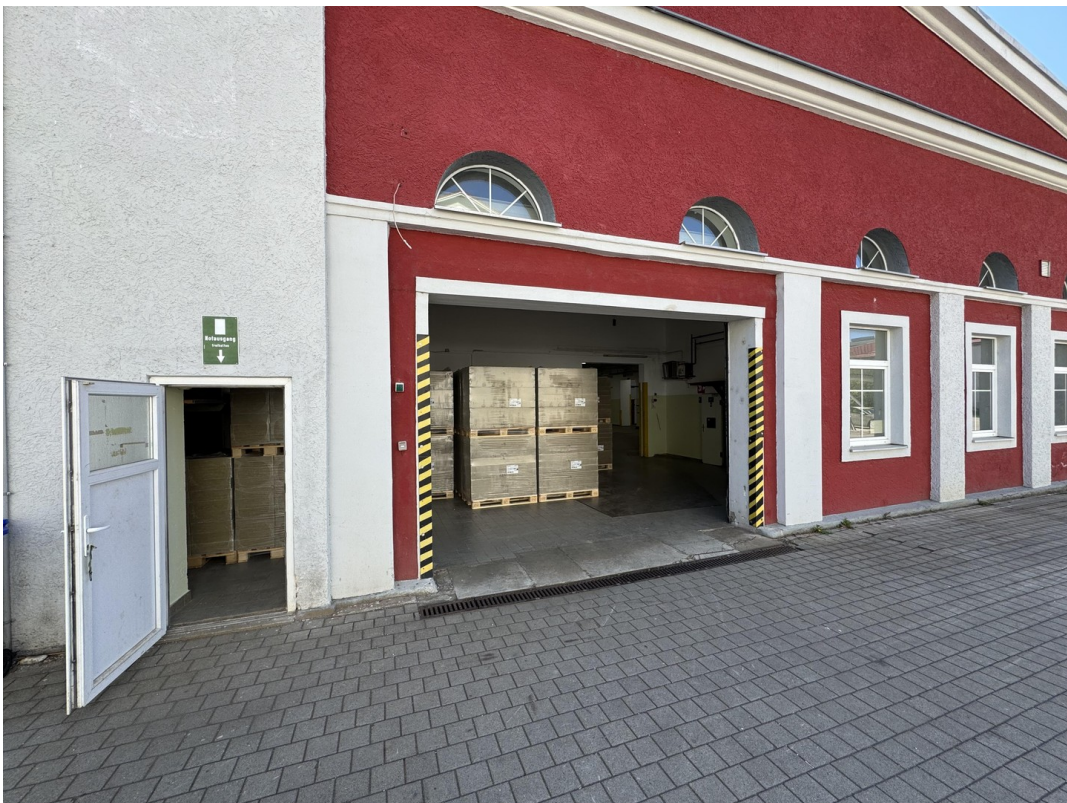
Rolltor Eingang West
