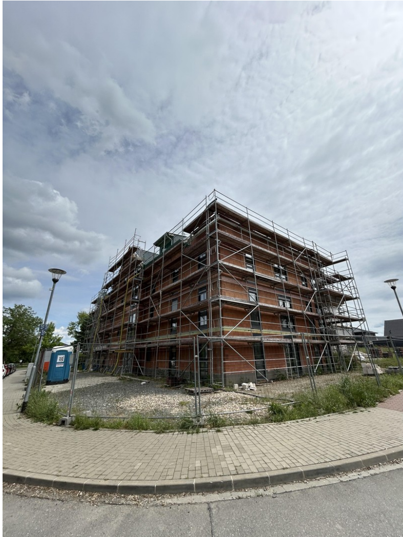
Aktueller Zustand seitlich
