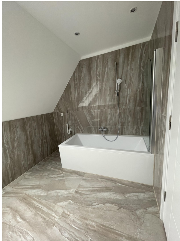
Bad mit Waschmaschinenplatz
