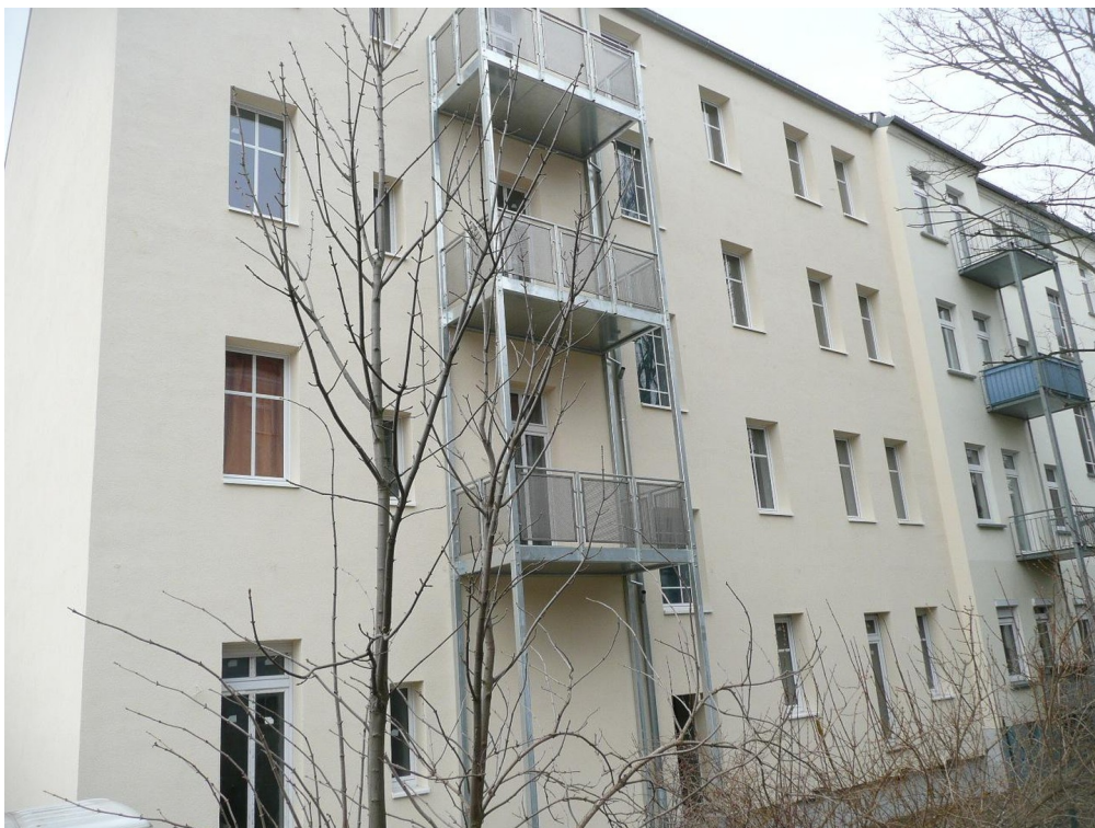
rückw. Ansicht Quergebäude
