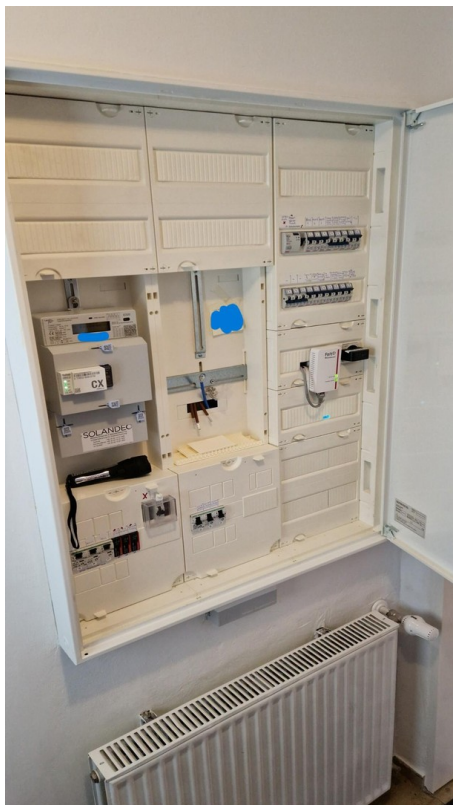
neuer Stromkasten/SmartMeter
