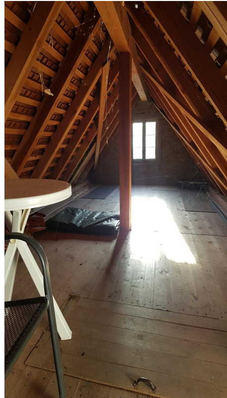
Stauraum über Garage
