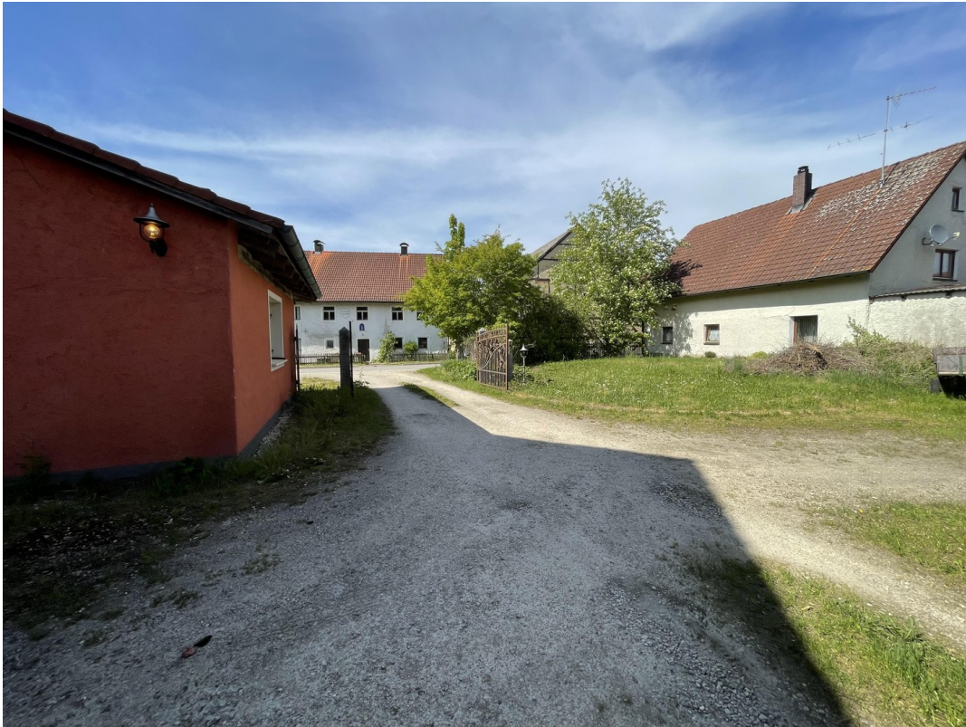
Blick aus Hofraum nach Norden
