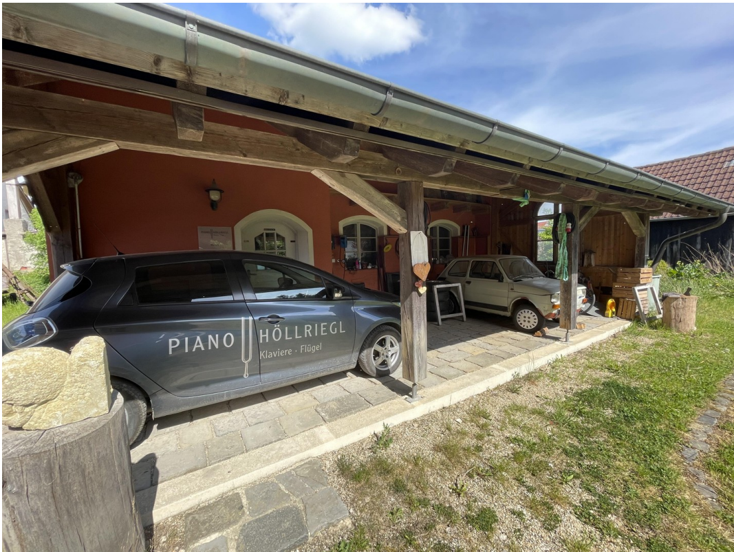
Vordach der Werkstatt
