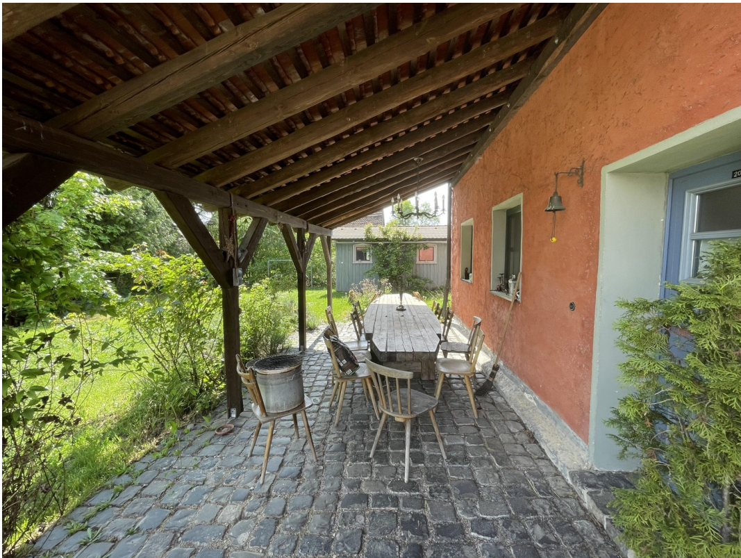
Vordach am Eingangsbereich
