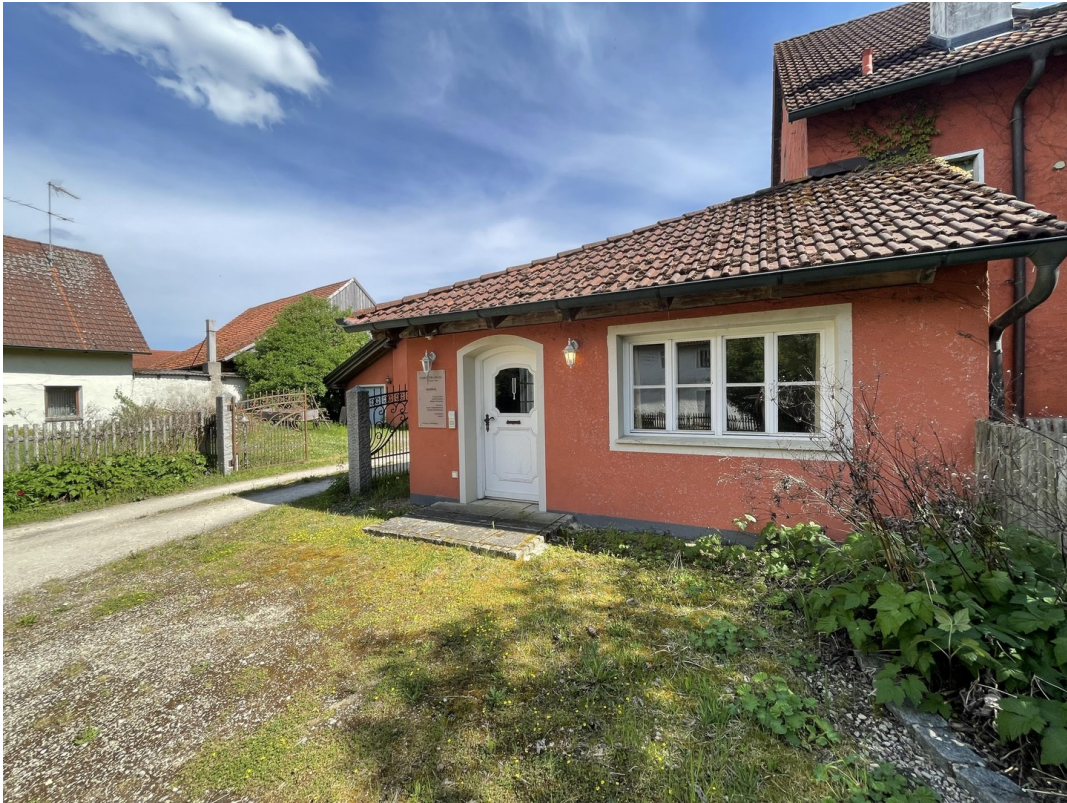
Ansicht Anbau Norden
