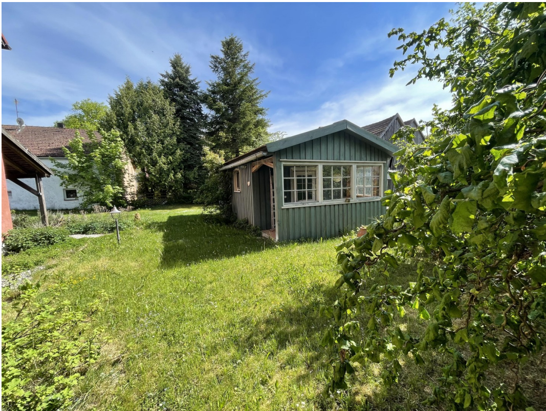
Ansicht Garage Norden
