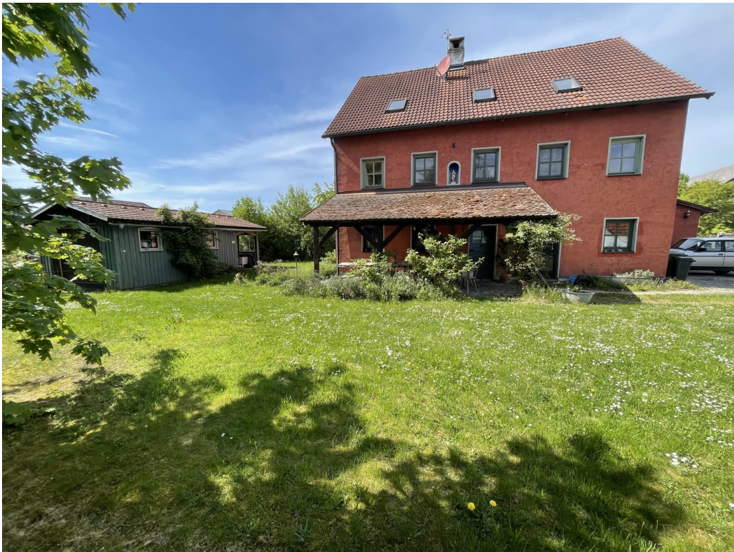
Ansicht Süden mit Garage
