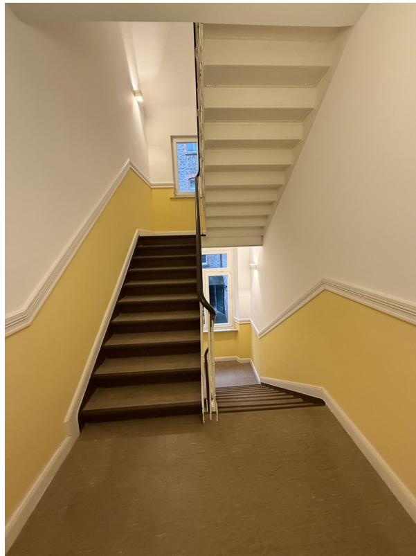
Blick ins Treppenhaus
