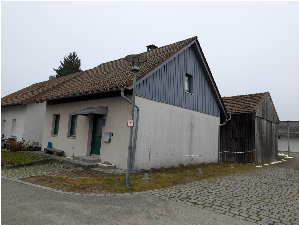
Haus mit Nebengebäude
