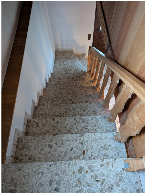
Treppe ins OG
