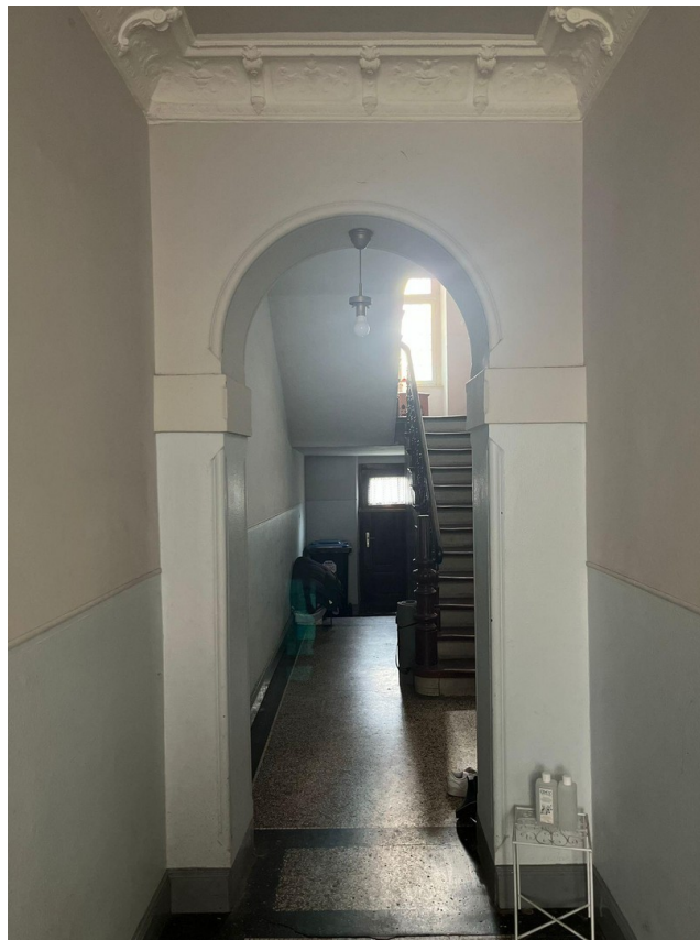
EG Hauseingang - Flur
