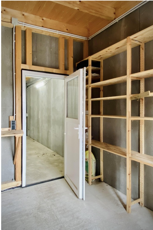
Lager/Werkstatt neben Garage
