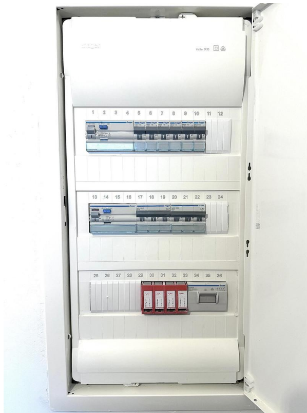
Sicherungskasten
