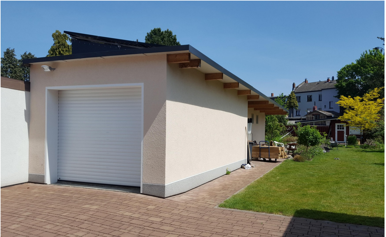
Garage +angrenzendem Holzlager
