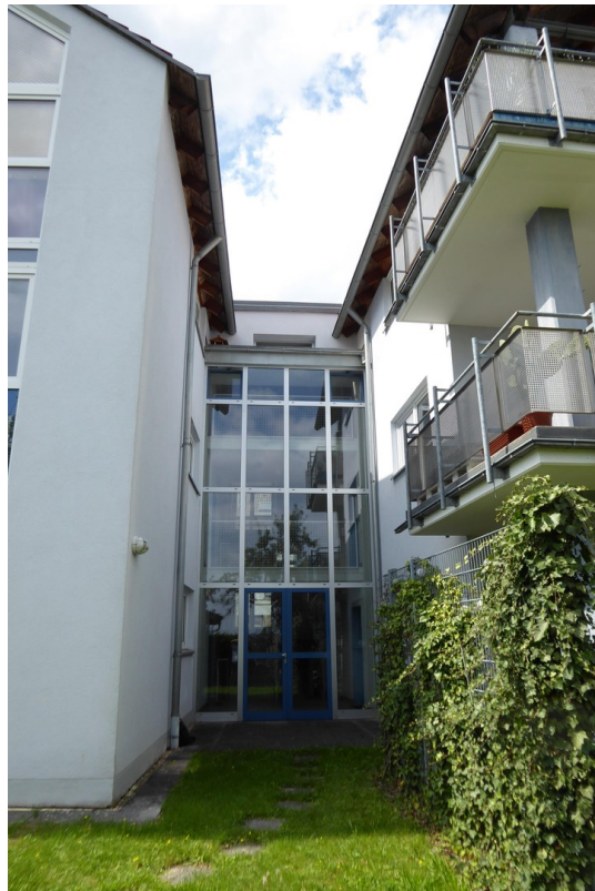
Ansicht Ost Treppenhaus
