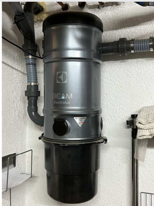
Zentrale Staubsaugeranlage
