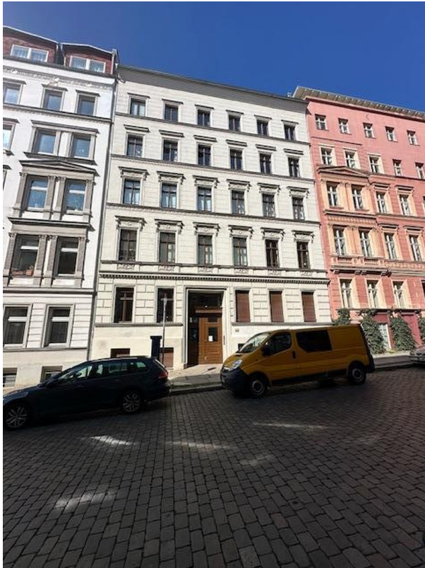
Fassade Vorderhaus Bild 1
