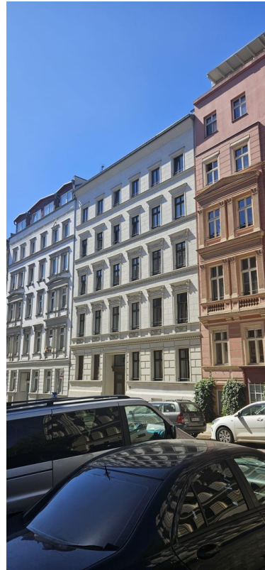
Fassade Vorderhuas Bild 2
