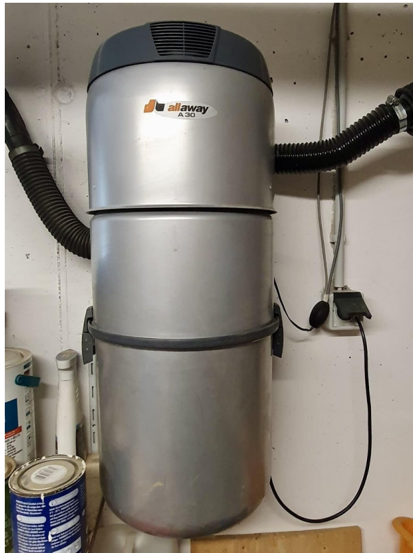
Staubsaugeranlage
