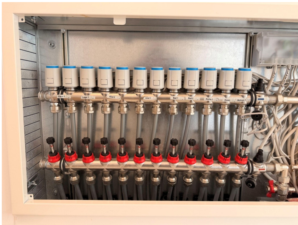
15 Fußbodenheizung
