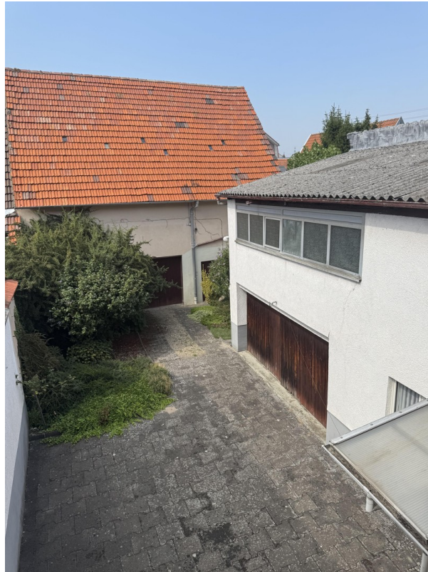
Innenhof und Blick zur Scheune
