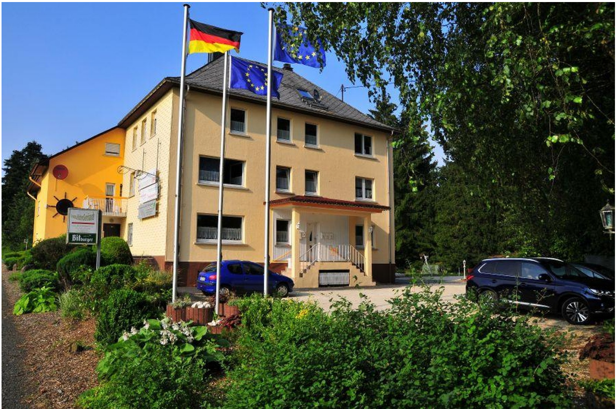
Hauptgebäude von West
