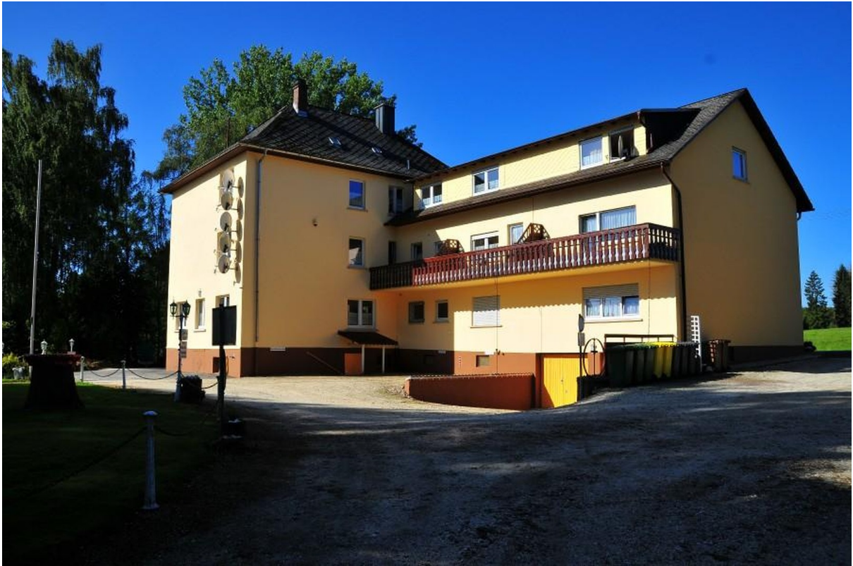
Hauptgebäude von Ost
