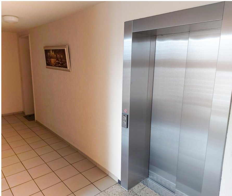
Treppenhaus mit Aufzug
