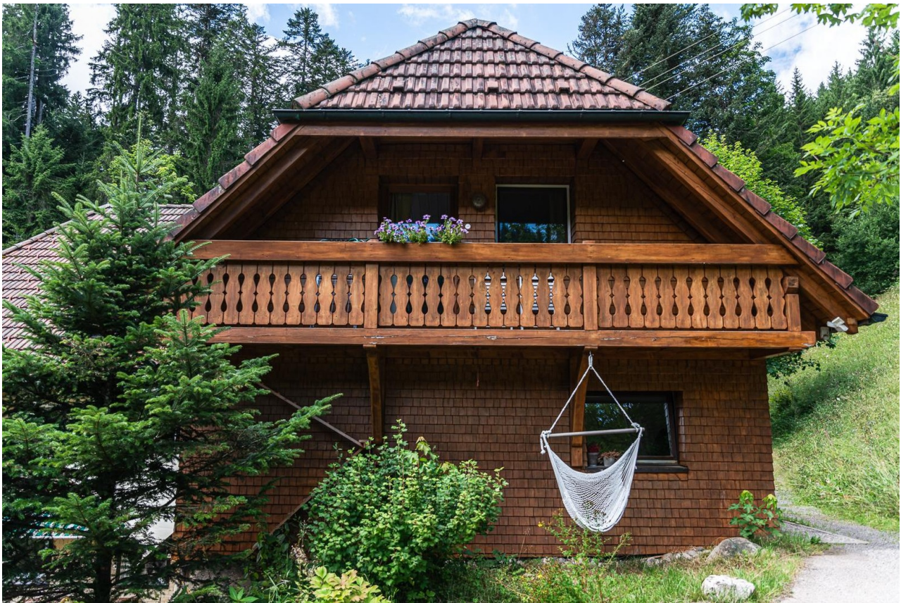
Ostseite mit Holzschindeln
