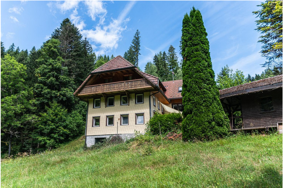
Südseite des Hauses
