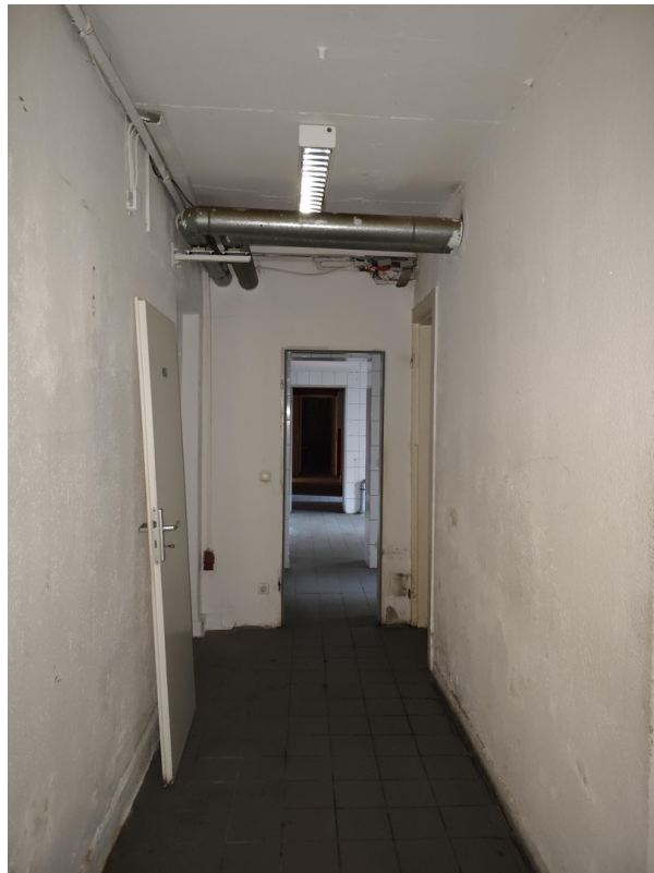
Zugangsflur hinterer Bereich
