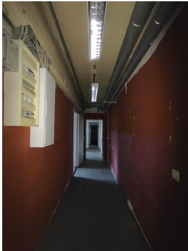
Zugangflur hinterer Bereich
