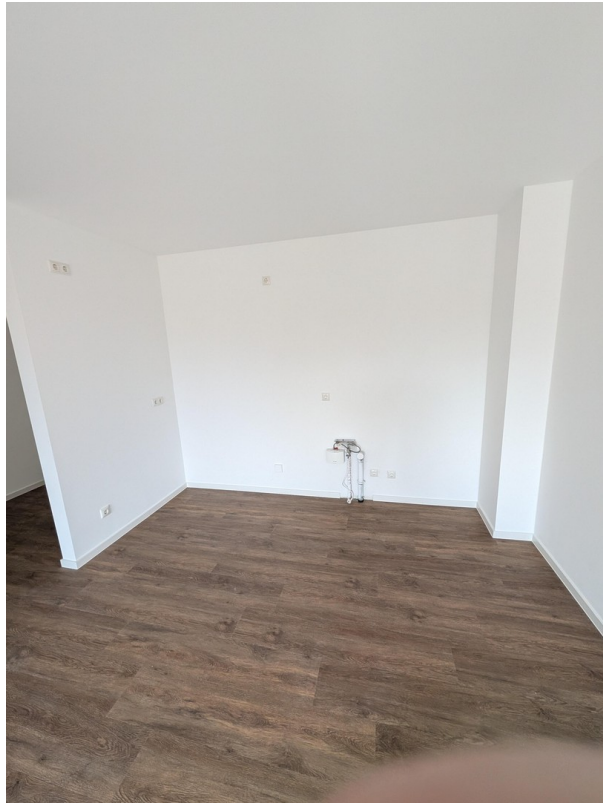
Küchen (Küche wird montiert)
