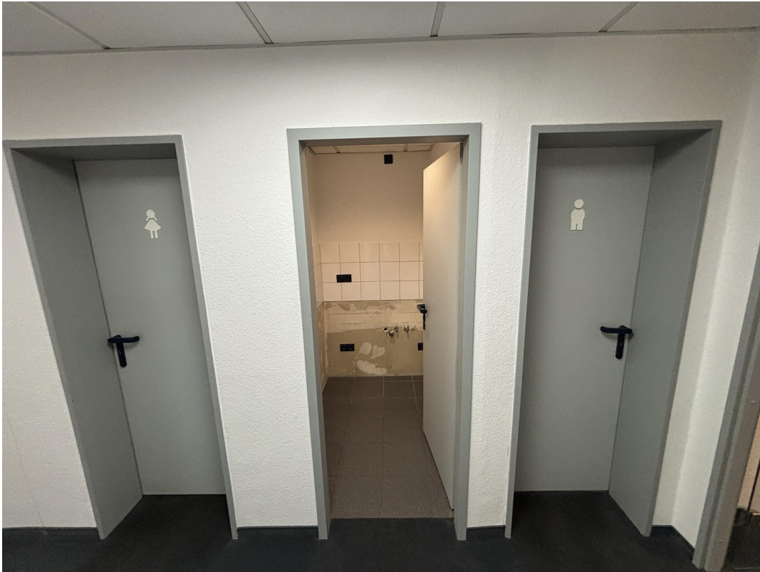
WC Anlagen 1 + Teeküche
