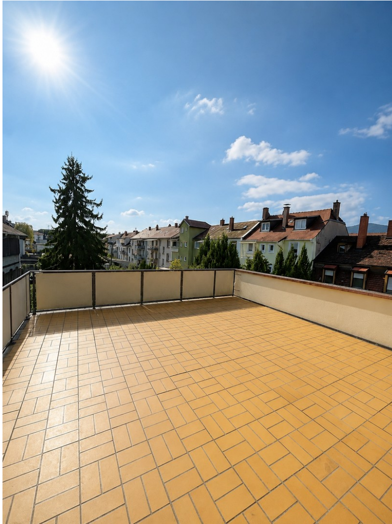
Dachterrasse vor Modernisierung
