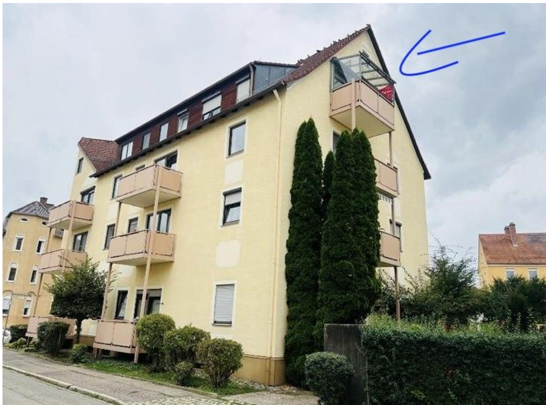
Hausansicht mit Balkon
