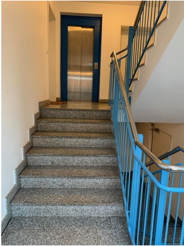
Treppenhaus mit Fahrstuhl
