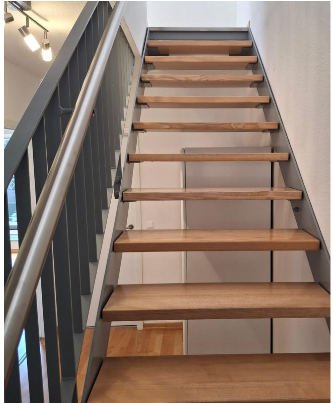
Treppe zu oberen Etage
