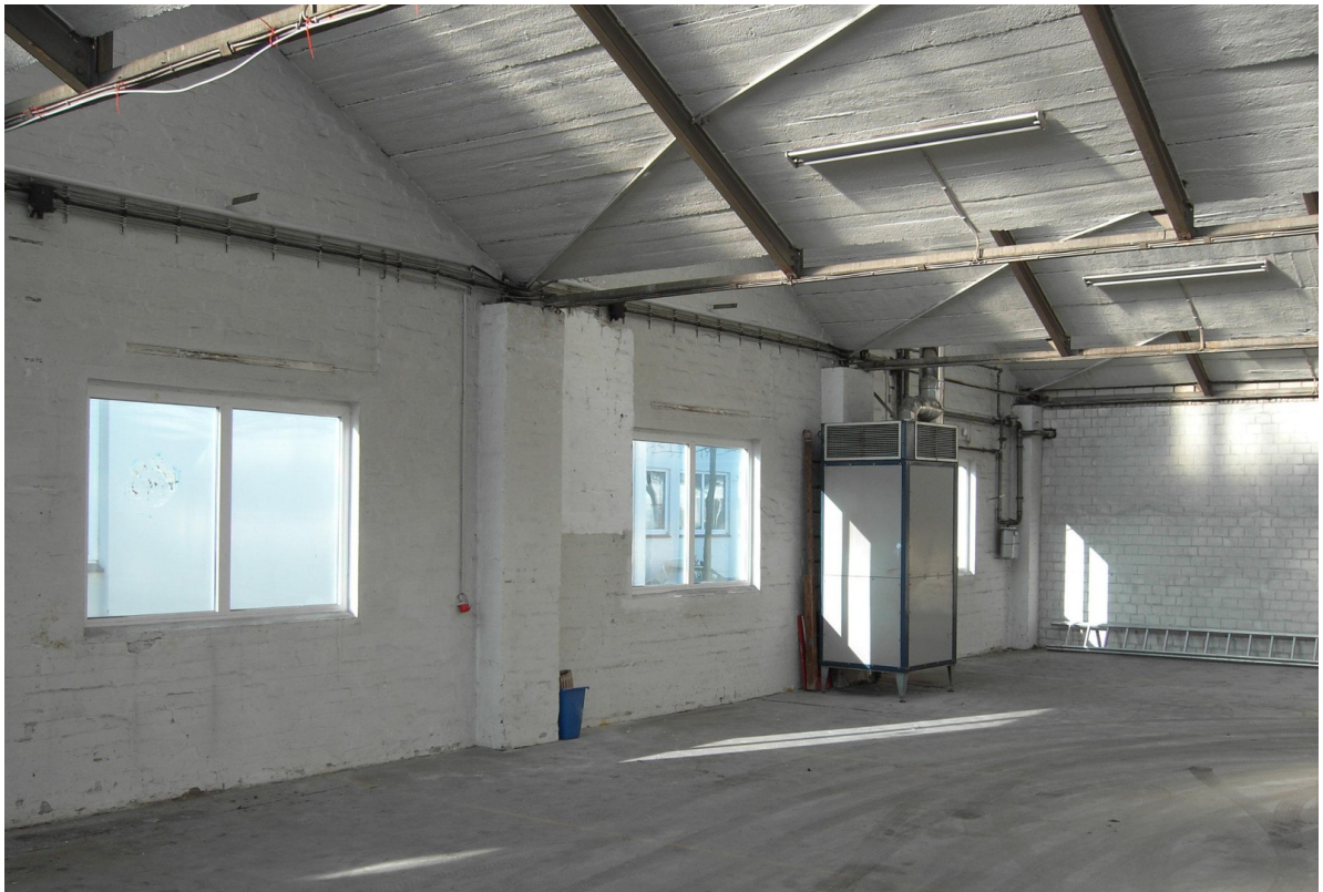
Gas-Luft-Heizung
