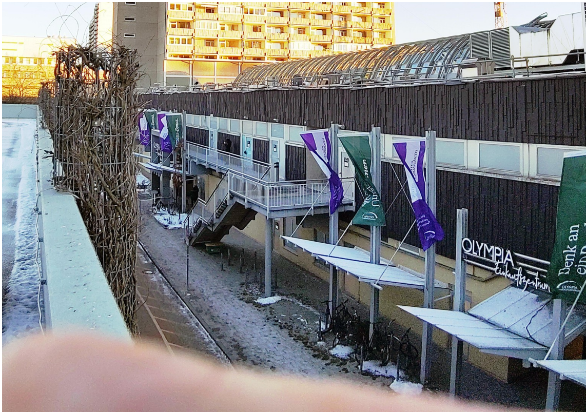
OEZ Nordseite mit Haus 65
