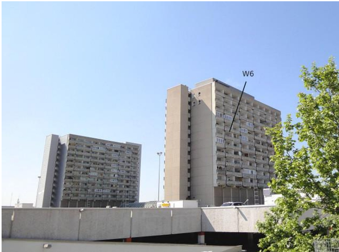
Lage im Gebäude von Süd-Osten
