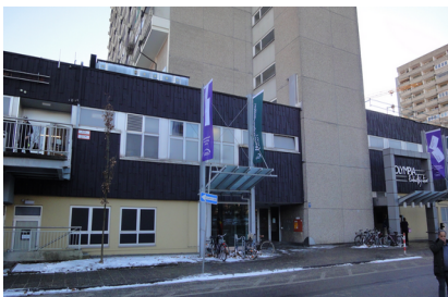
Nordseite OEZ mit Eingang Haus 65
