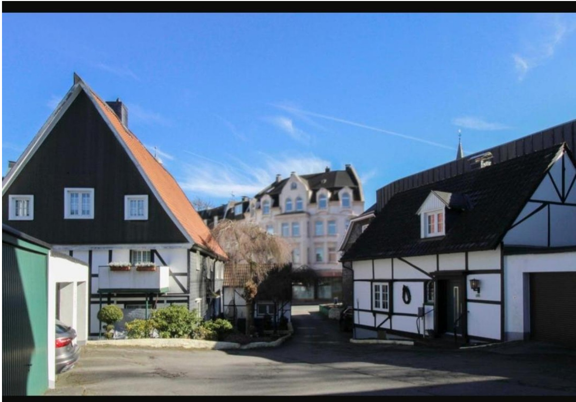
Ansicht von Haus 7b
