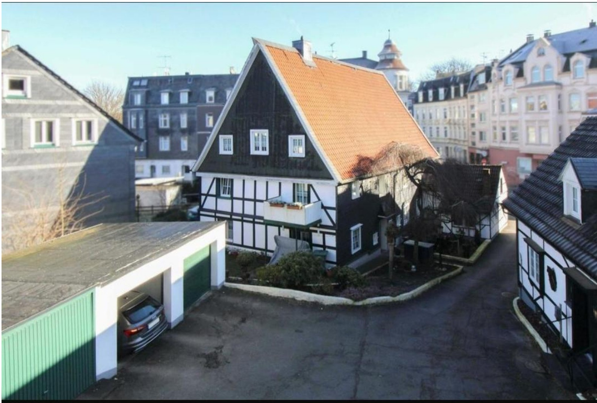
Ansicht von Haus 7b
