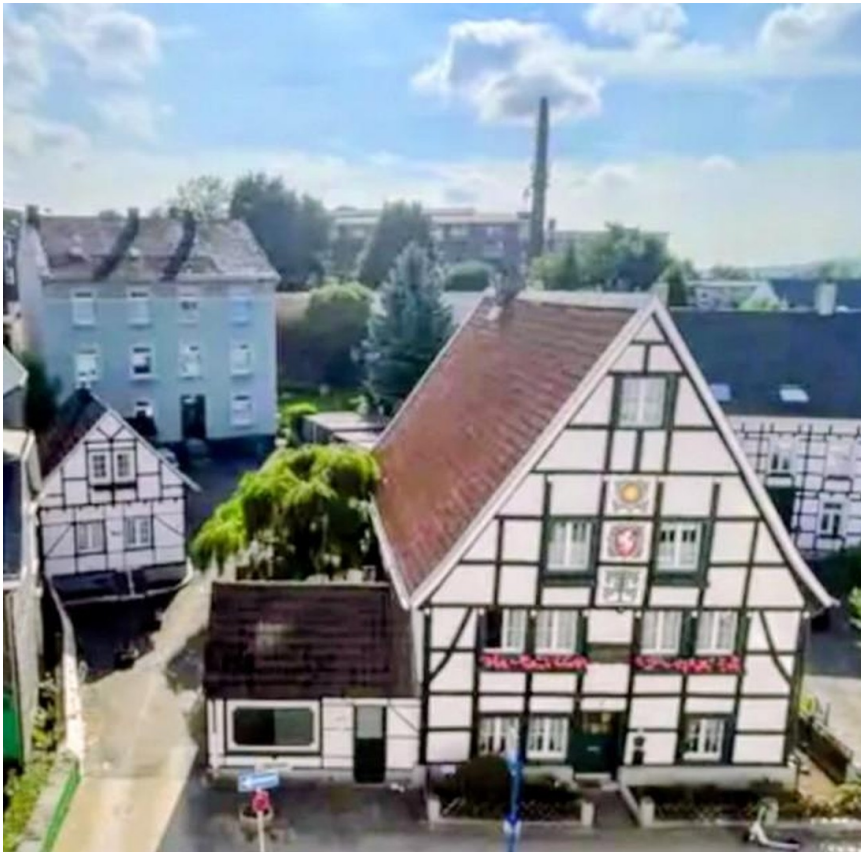
Front Objekt oben
