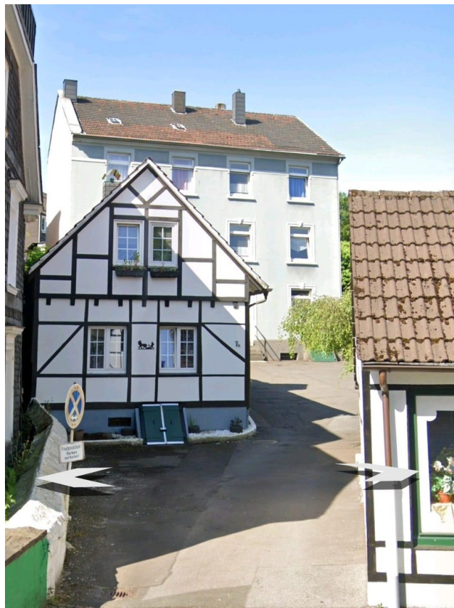
Blick von der Straße
