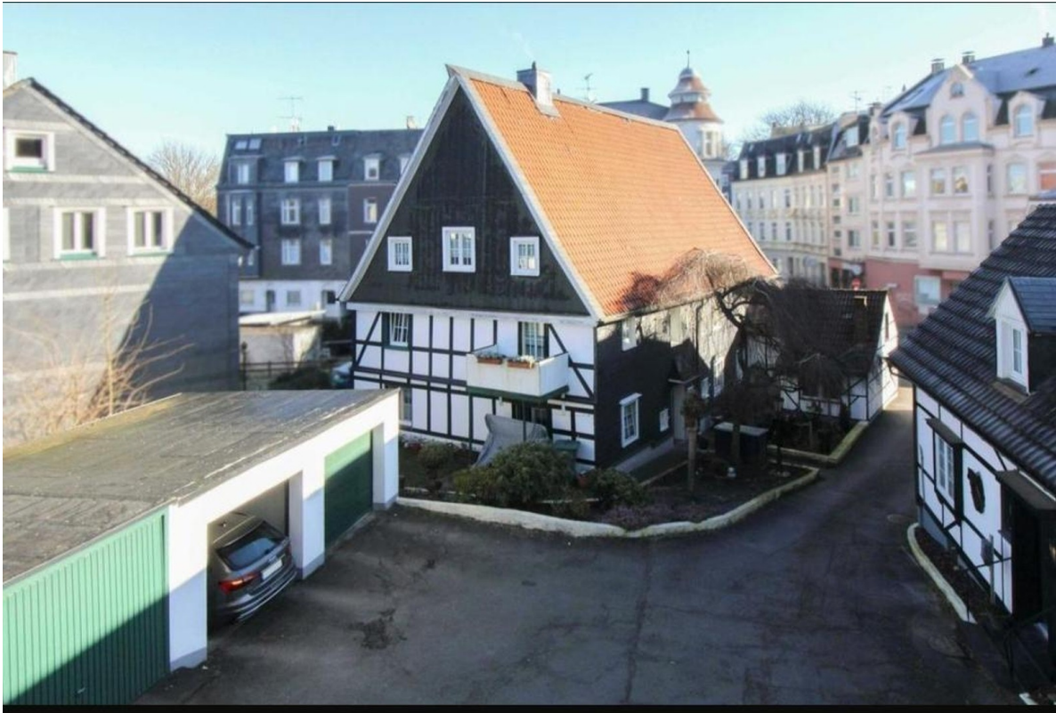
Ansicht von Haus 7b
