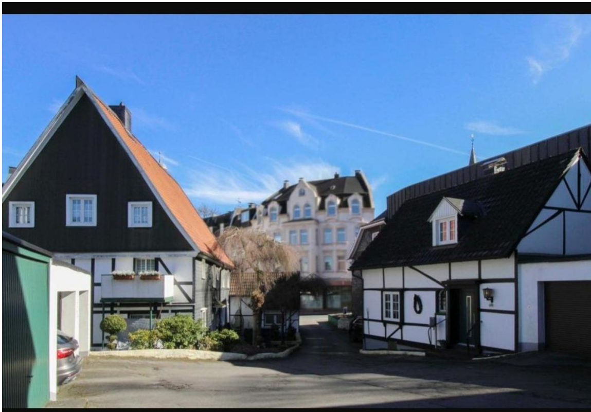
Ansicht von Haus 7b
