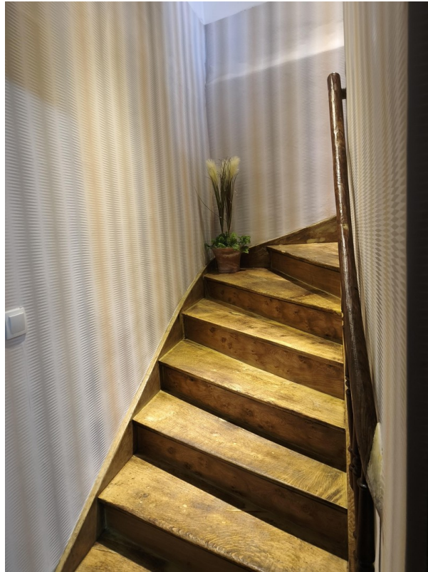
Treppe zu 3.OG
