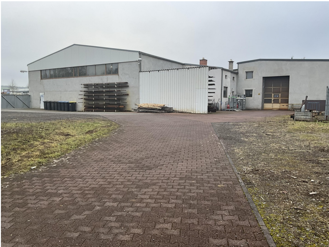
Halle 1 links, Halle 2 rechts
