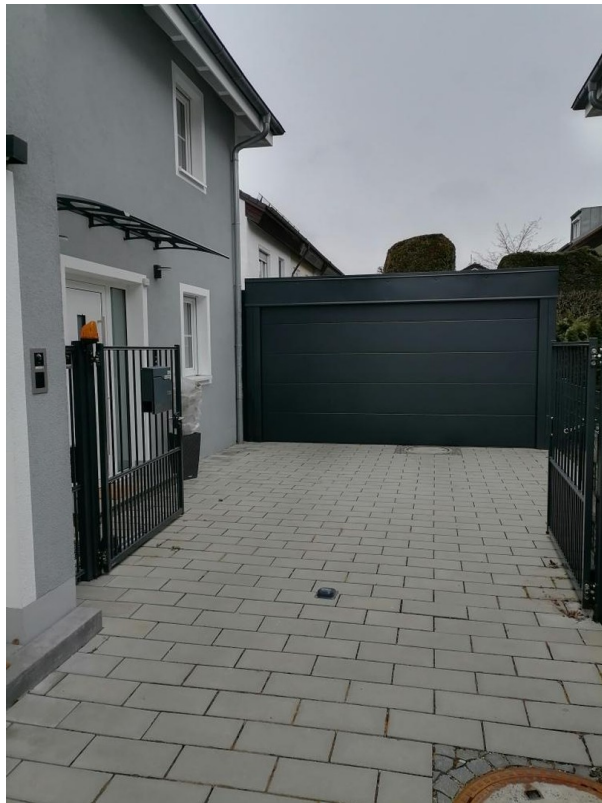
Einfahrtstor und Doppelcarport
