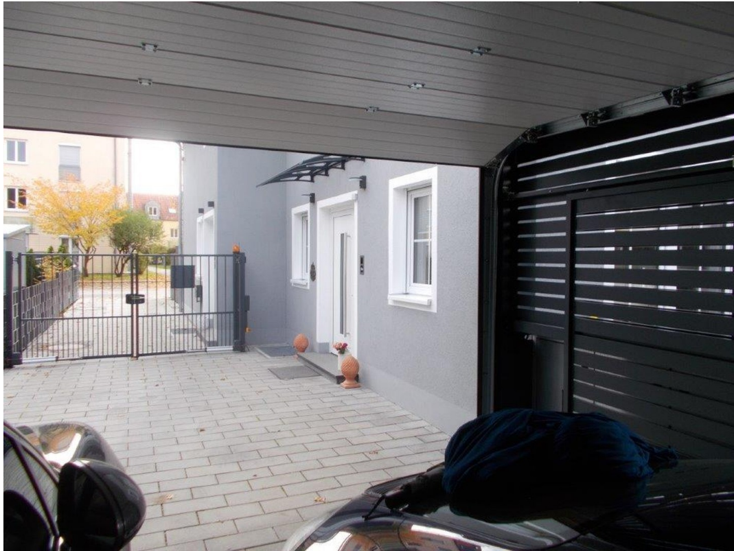
Vorplatz mit Einfahrtstor
