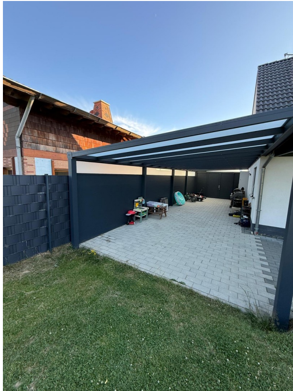
Überdachung neben dem Haus
