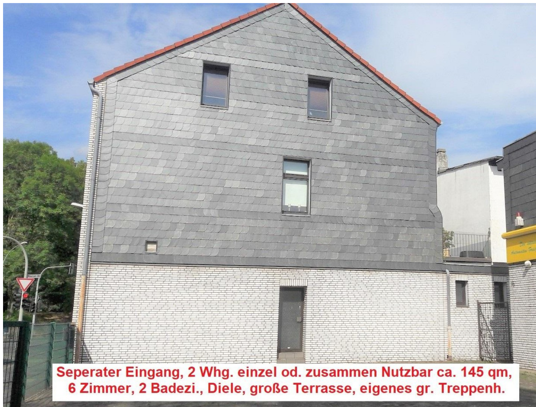
Seitenansicht Haus A
