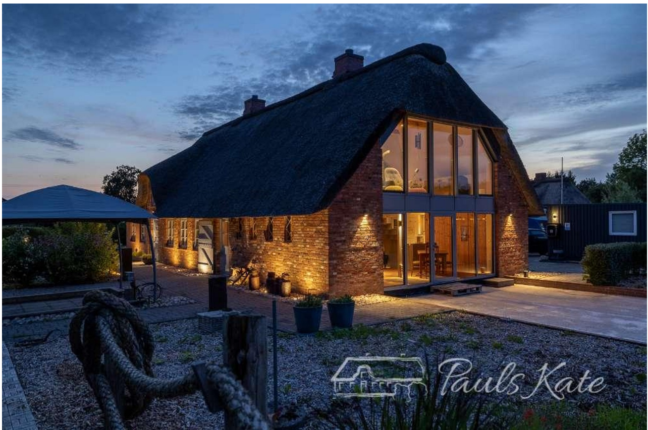
Ostseite mit Glasfassade
