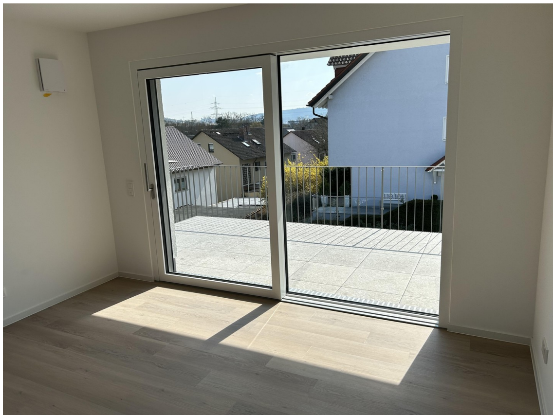
Hebeschiebetüre zum Balkon
