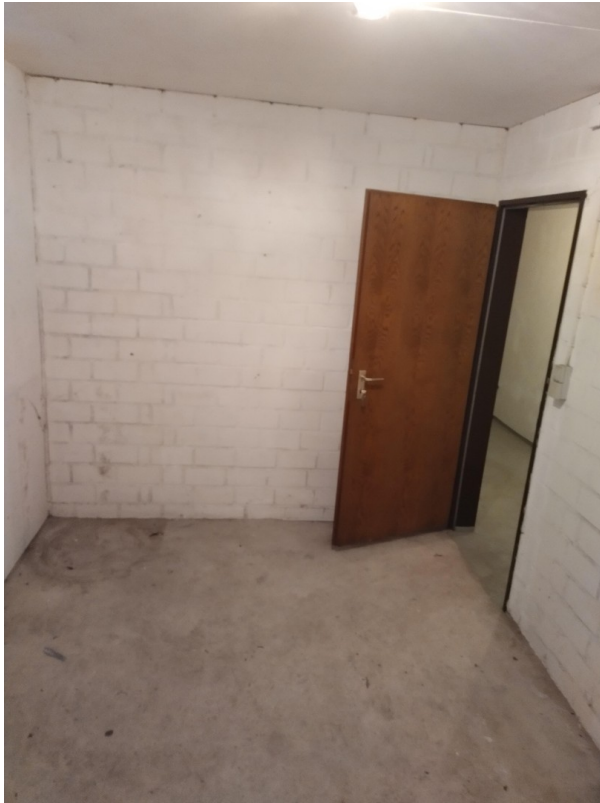
Abstellraum im Keller
