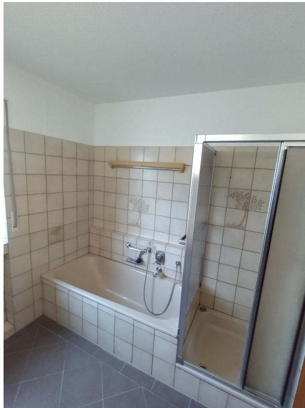
Bad Blick Dusche und Wanne
