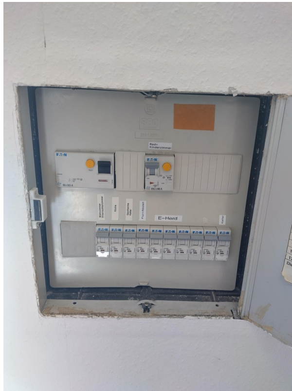
moderner Sicherungskasten
