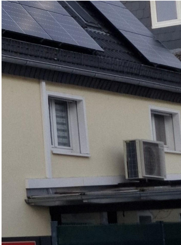
Klima Splittgerät Außeneinheit
