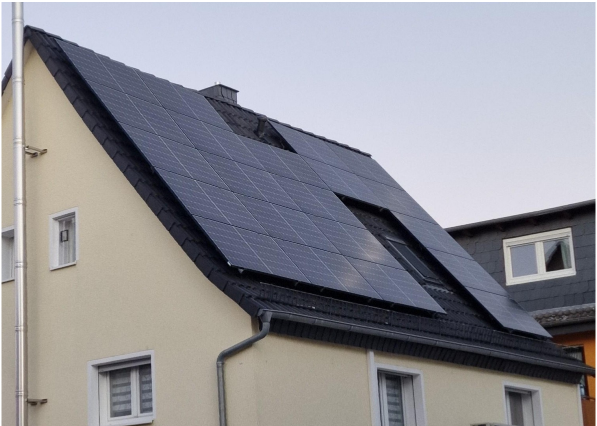
7,98 kWp PV-Anlage
