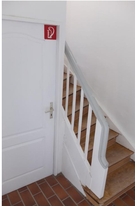
EG zu OG Treppe zur Wohnung
