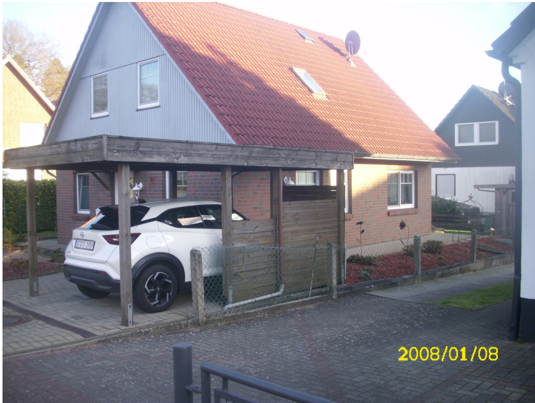
Carport steht vorne
