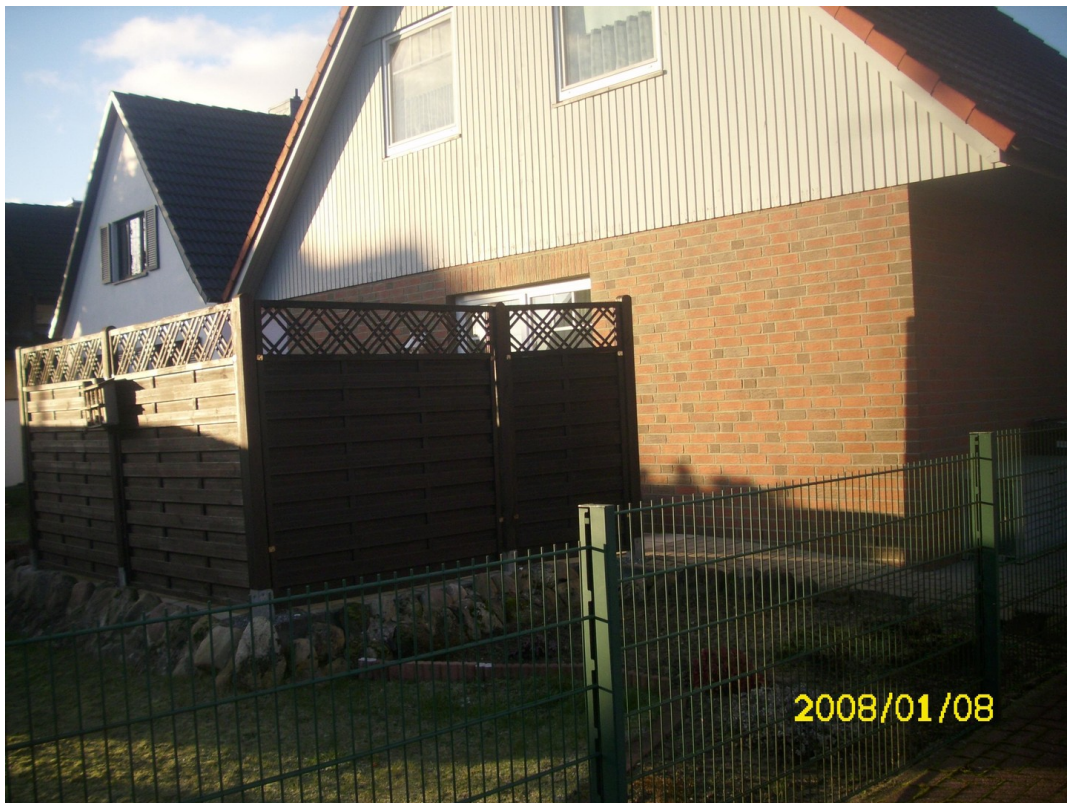
Terrasse mit Sichtschutz
