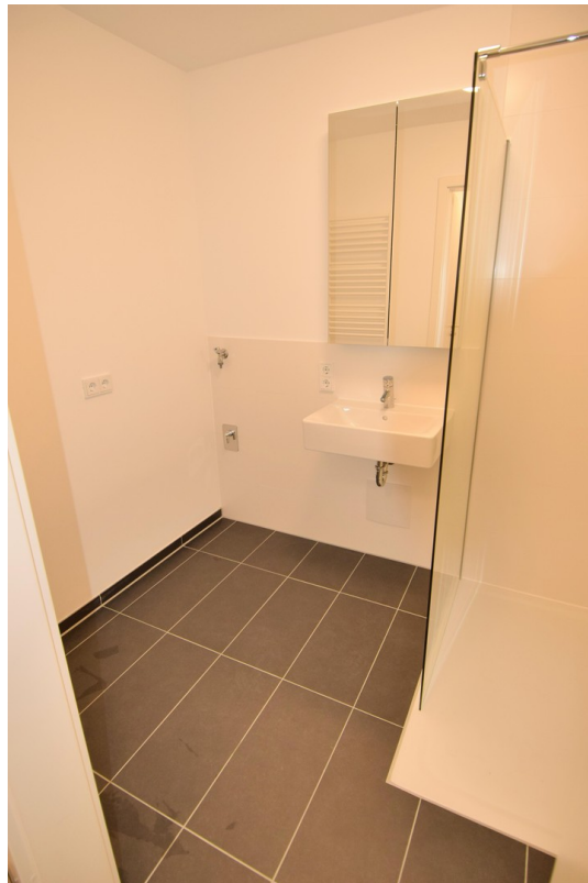
Bad / Waschmaschine Trockner
