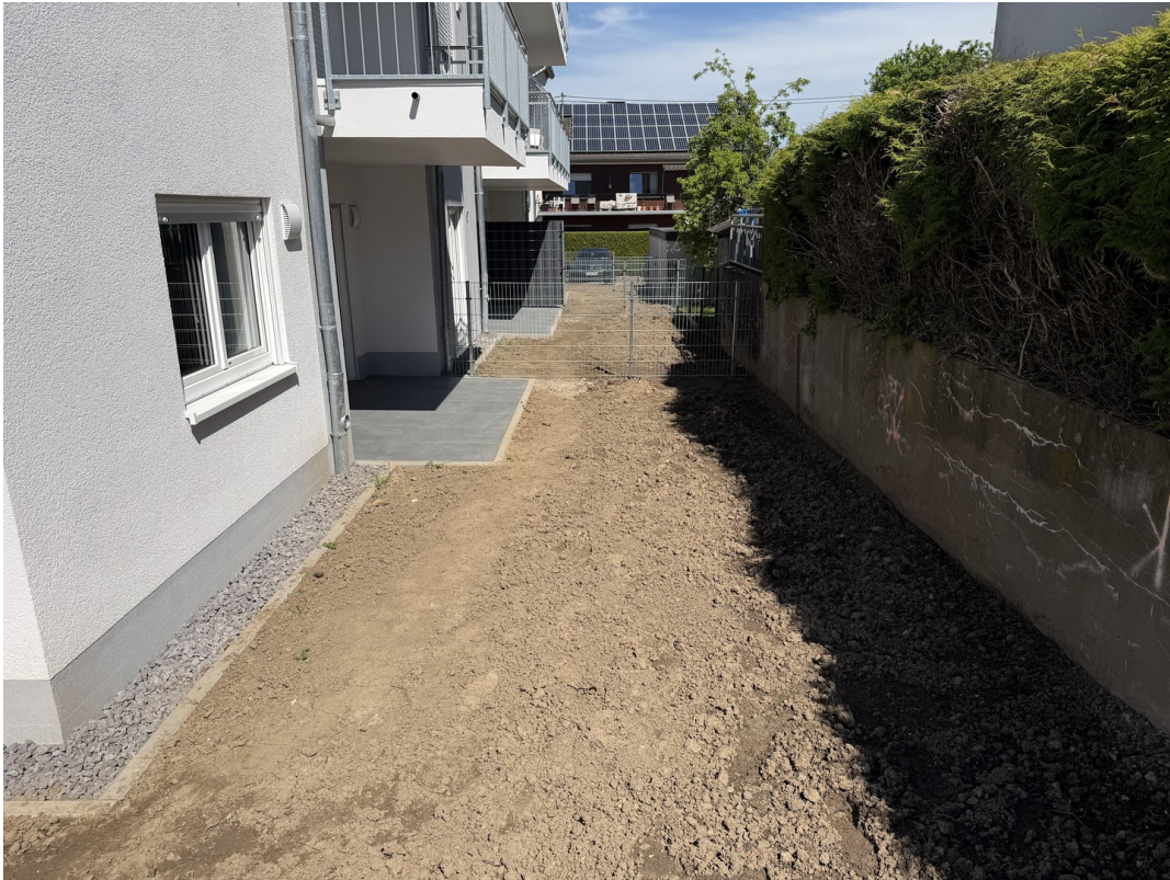
EG re. Garten_Terrasse Sicht
