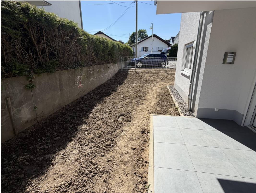
EG re. Terrasse außen Sicht 1
