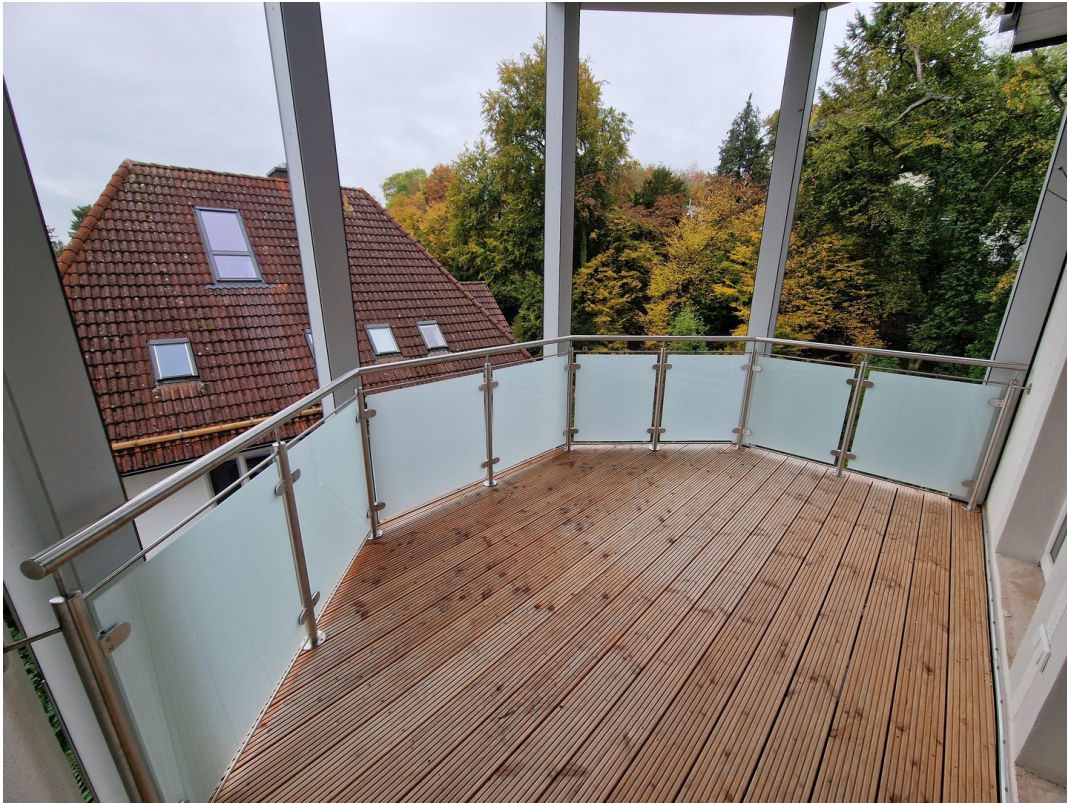
Überdachte Balkone EG und OG
