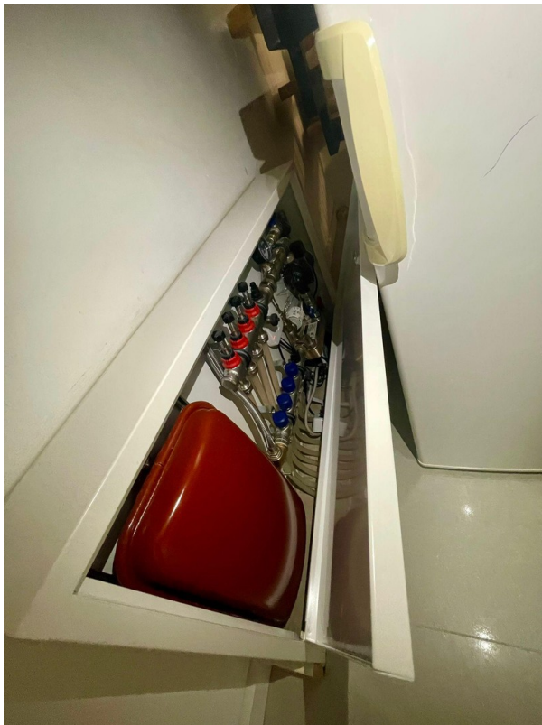
Fußbodenheizung
